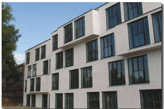
Haus 1 der „Campus Appartements“ ist fast fertig
